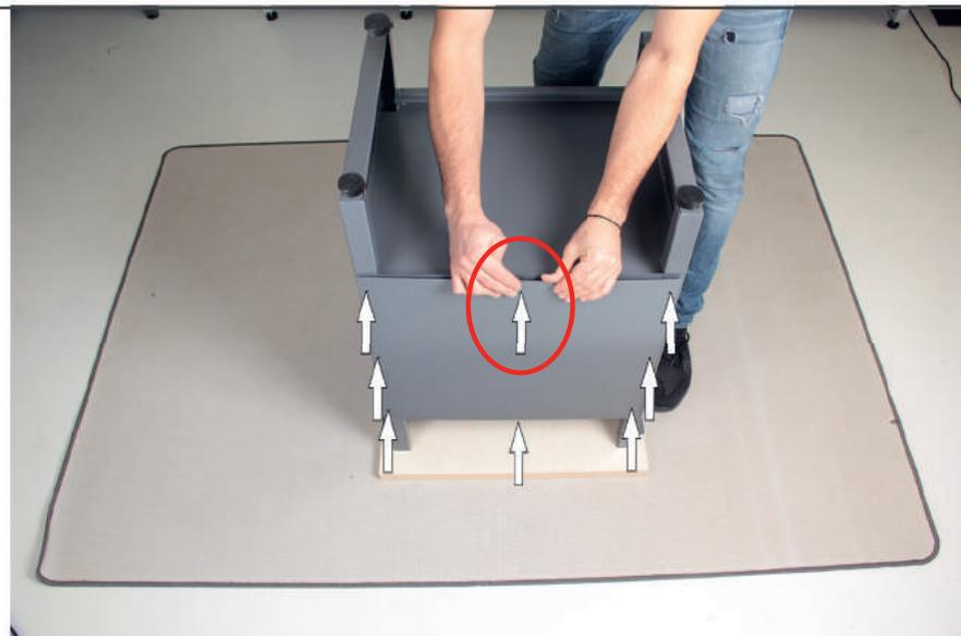
**Tip:** Schrauben Sie die Rückwand zunächst wie dargestellt mit zwei Schraubensets M5x8 an die mittleren Löcher des Fachbodens.
